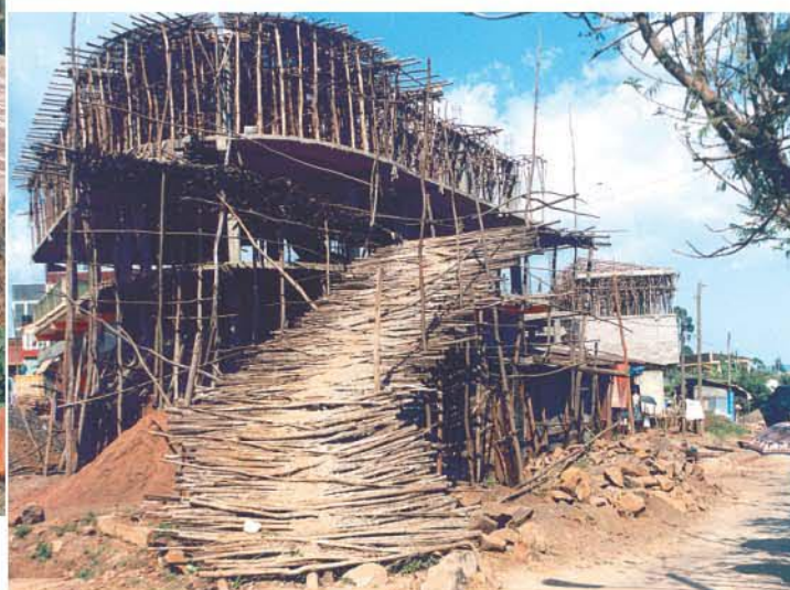
INSOLITO. Observen las escaleras y los andamios, así se construyen los edificios de 4 a 12 pisos.
